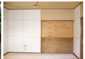
内部耐震補強
