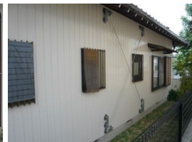
外部耐震補強2
