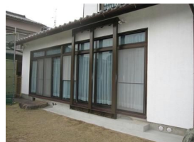
外部耐震補強1
