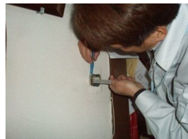
仕上げ材の調査
