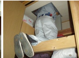
小屋裏の調査
